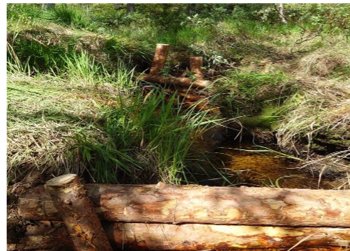
Träkonstruktioner (deflektorer) som stoppar upp vattenflödet och jämnar ut vattenhastigheten. Små vattendrag som detta får lite död ved till sig och med denna tillförsel ger det mer syre, föda åt insekter och hjälper till att få bort finpartiklar ur vattendraget.
