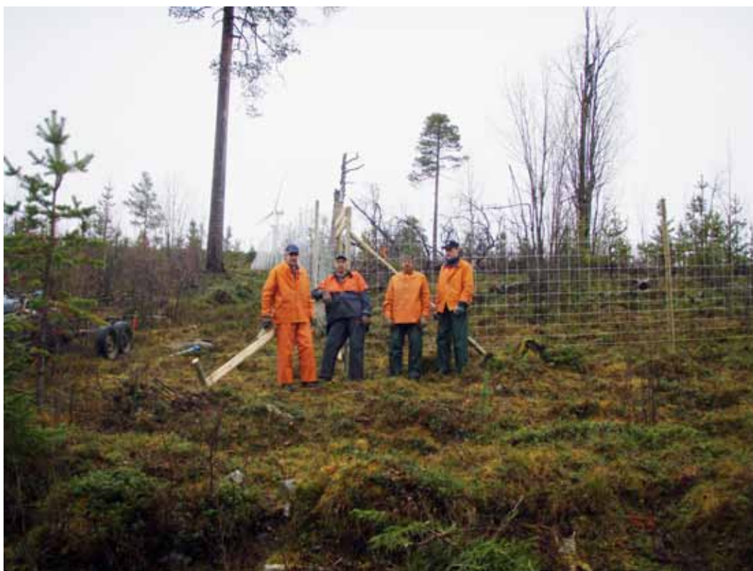
Instängt. Den första stängslingen skedde på norrsidan Etu-Aapua hösten 2007 av Korju sameby. Syftet är att stänga ut framförallt älg så att sälg och asp kan klara sig.
